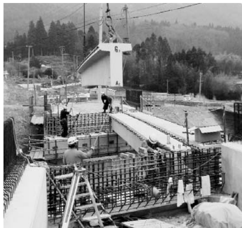
箱根橋工事現場
